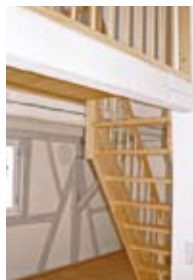
▲ Konstruktionselemente des Dachstuhls bleiben im Dachgeschoss sichtbar.
