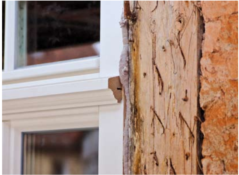
▲ Fachgerechte Einpassung der Wärmeschutzfenster in die Fachwerkkonstruktion. Trotz der nach dem historischen Vorbild minimierten Fensterprofile erreichen sie mit Dreischeiben-Isolierverglasung sehr gute Dämmwerte.
