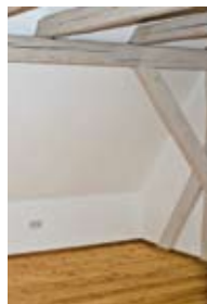
▲ Konstruktionselemente des Dachstuhls bleiben im Dachgeschoss sichtbar.
