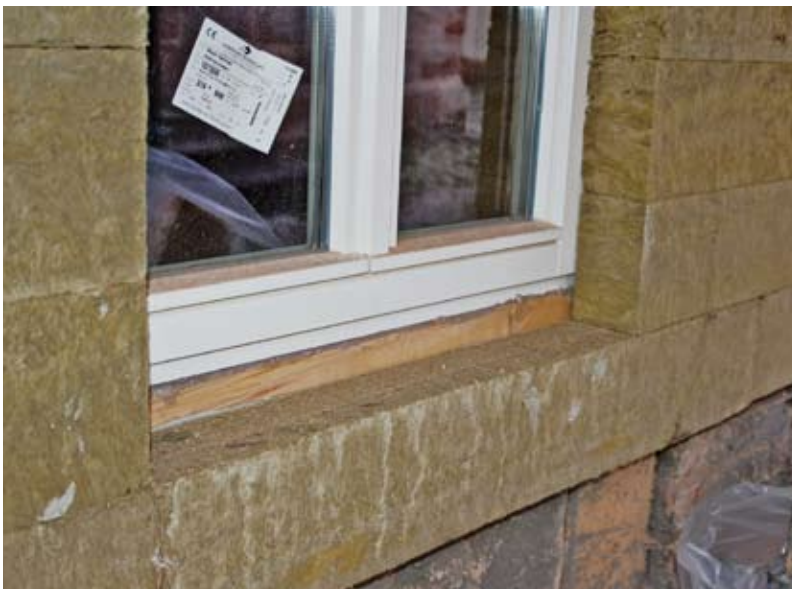
▲ Die unter dem Putz aufgebrachte Dämmung der Außenwände aus 10 cm starker Steinwolle trägt dazu bei, dass für diesen Altbau Primärenergieverbrauchswerte erreicht werden, die nahezu dem Passivhausstandard entsprechen.
