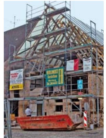
▲ Zum Schutz der Bausubstanz des Hauses vor Feuchtigkeit wurde das freigelegte Dachgebälk bis zur Neueindeckung mit einem Schutzdach abgedeckt.
