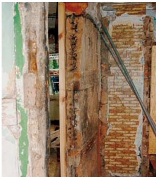
▲ Der Zustand des Hauses zu Beginn der Baumaßnahmen. Deutlich sind Durchfeuchtungen des Fassadenputzes zu erkennen, die auf gravierende Schäden in der Dachkonstruktion hingewiesen haben.
