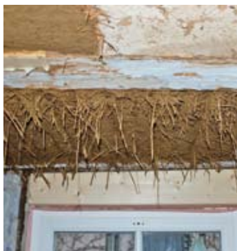
▲ Ersatz beschädigter Decken und Wände mit Material, das der ursprünglichen Bauweise entspricht: Lehmwickel zur Deckendämmung sowie Lehm, Stroh und Holz zur Ergänzung der Gefache in der Fachwerkkonstruktion.
