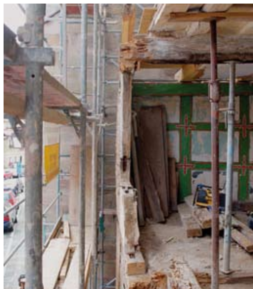
▲ Der Zustand des Hauses zu Beginn der Baumaßnahmen. Deutlich sind Durchfeuchtungen des Fassadenputzes zu erkennen, die auf gravierende Schäden in der Dachkonstruktion hingewiesen haben.
