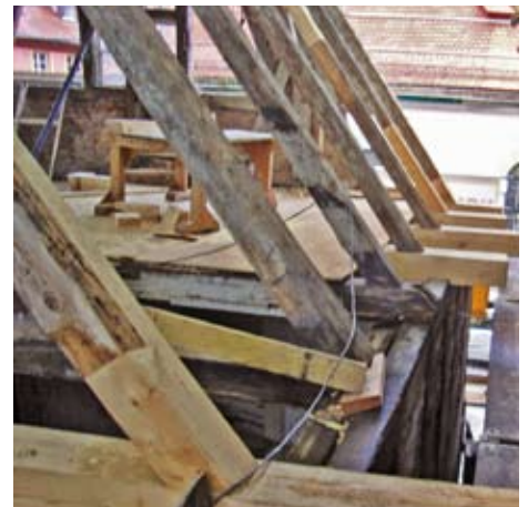
▲ Sanierung der substanziell stark beschädigten Dachbalken durch Ergänzung neuer Teile. Lage und Umfang der Schäden im Dachstuhl zeigt der Aufmaßplan aus dem Modernisierungsgutachten auf Seite 11 unten.
