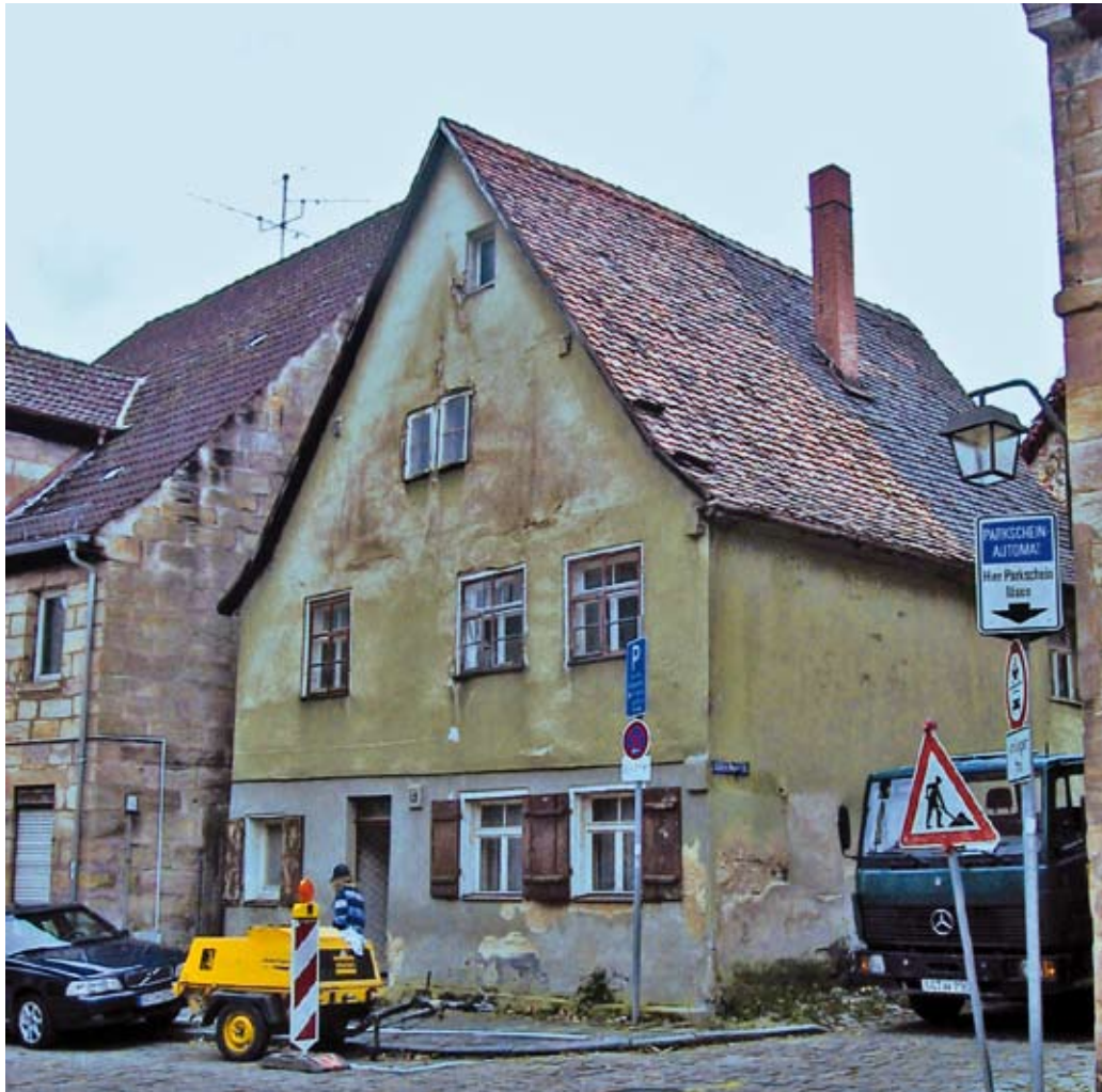
▲ Der Zustand des Hauses zu Beginn der Baumaßnahmen. Deutlich sind Durchfeuchtungen des Fassadenputzes zu erkennen, die auf gravierende Schäden in der Dachkonstruktion hingewiesen haben.
