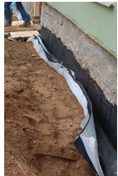
▲ Eine Feuchtigkeitsabdichtung im Keller- und Erdgeschoss hilft dabei, die Außenwände trocken zu halten. Innen laufen im Sockel- und Brüstungsbereich Heizungsrohre aus Kupfer, um die Wände zu temperieren.
