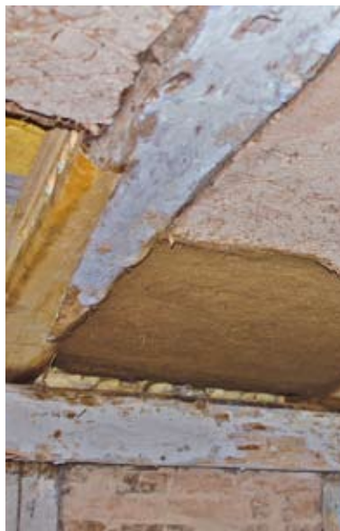
▲ Alte Bausubstanz wurde weitgehend erhalten, beschädigte Balken mit gleichartigem Holz ergänzt und Decken- oder Wandflächen in Lehmbauweise instandgesetzt.
