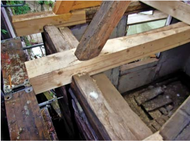
▲ Schadhafte Teile der Fachwerkkonstruktion mussten ersetzt werden, um die statische Stabilität des Hauses wiederherzustellen. Diese Arbeiten wurden zimmermannsmäßig nach historischen Vorbildern und mit den entsprechenden Holzarten ausgeführt.
